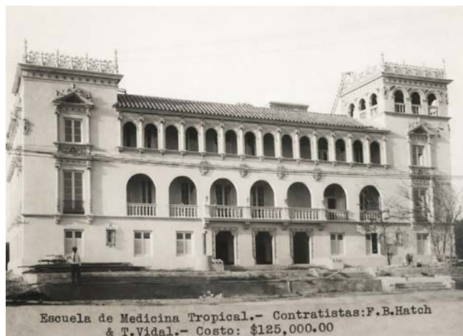
Figura 4. Fotografía luego de concluir la construcción de la Escuela de Medicina Tropical. Fuente: Fondo Obras Públicas, Archivo Fotográfico, AGPR. Suministrada por Daniel Mora Ortiz.
